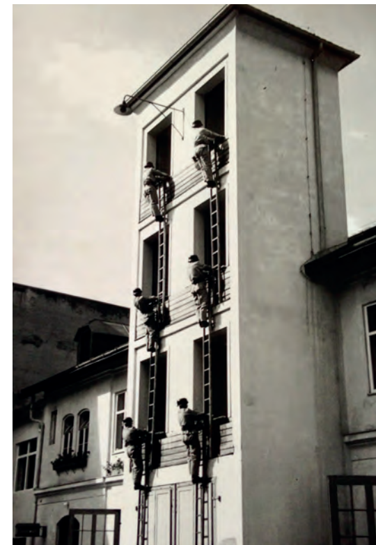
1960 Übung am 1959 errichteten Turm (1)
