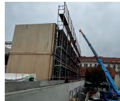
2024 1. und 2. OG im Bau (1)
