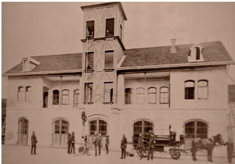
1889 Neu erbautes Rüsthaus (1)
