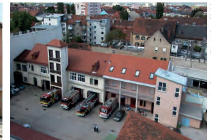
2001 Der fertiggestellte Umbau (1), (2)
