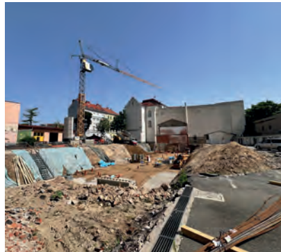
2024 Baugrube im Juni 2024 (1)
