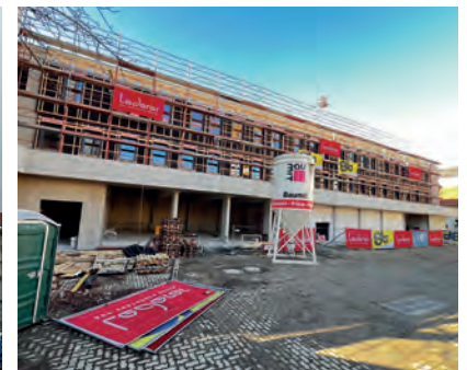
2024 Dachgleiche am 26. November (1)
