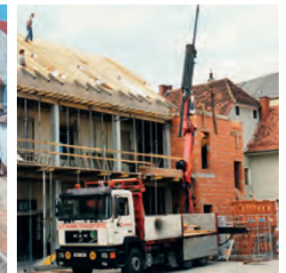
2001 Umbau Zimmer, Treppenhaus (1)
